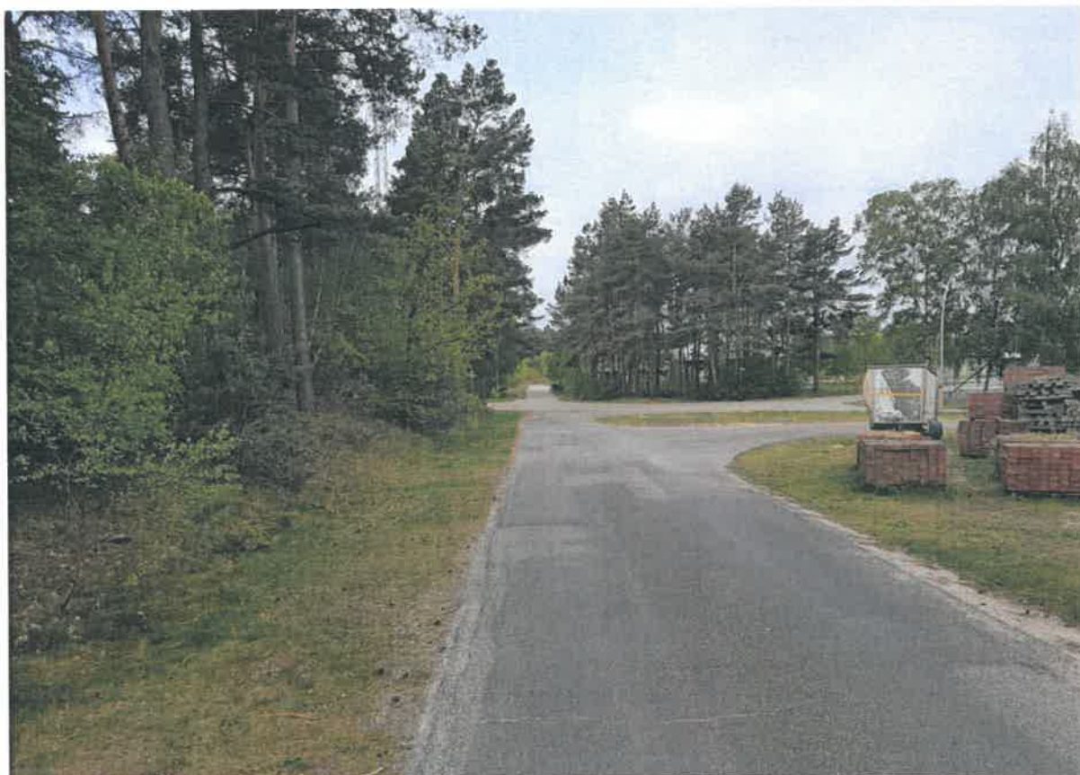
Abbildung 16 UG 2: Teerstraßen und Baustofflager im Bereich des alten BW-Depots
