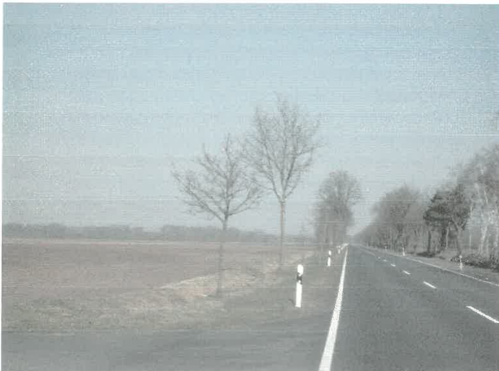
Abb.1 links: Ackerfläche im Geltungsbereich (Blickrichtung Nord), rechts: Kreisstraße K325, mittig: Baumreihe auf Grünbankett mit Entwässerungsmulde entlang der K 325
