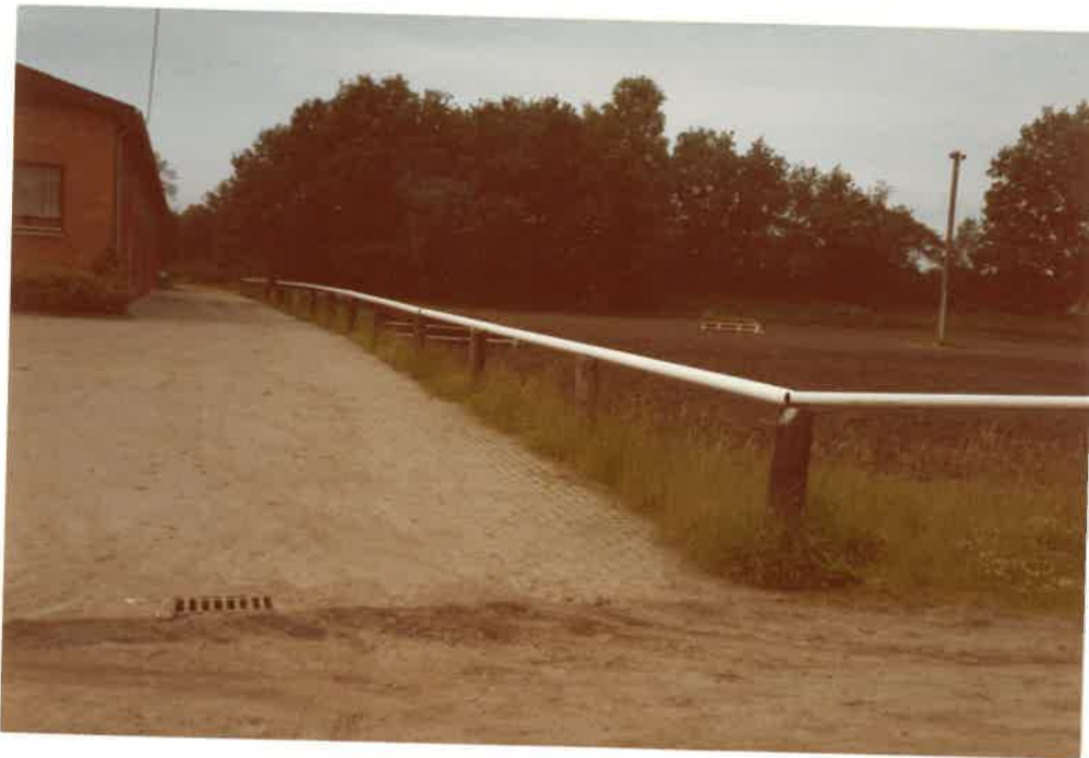
Blick von der Straße "Am Sportplatz" auf die Nahtstelle zwischen der Reithalle (links) und ihrem gepflasterten Stellplatz auf die Umzäunung des benachbarten Freigeländes für den Reitsport, das in einer späteren Erweiterung des Sportzentrums festgesetzt wird.
